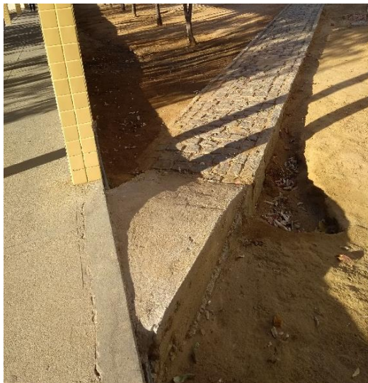
Figura 1 – Vista central da rampa de acesso da biblioteca do CERES/UFRN.
