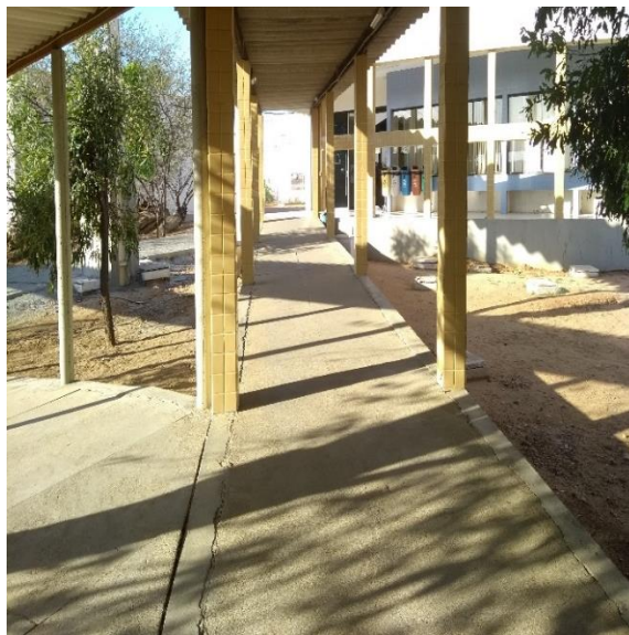
Figura 2 – Vista lateral da rampa de acesso da biblioteca do CERES/UFRN.
