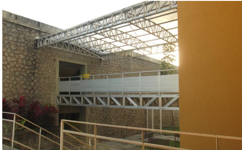
Figura 2 – Passagem entre os prédios: antigo e Anexo.
