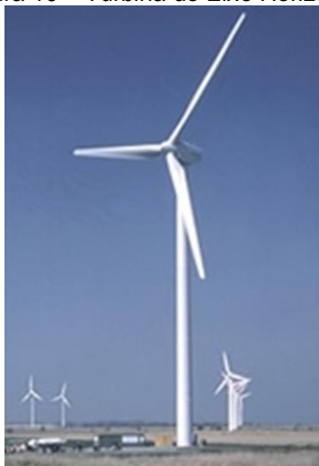
Figura 10 – Turbina do Eixo Horizontal.
