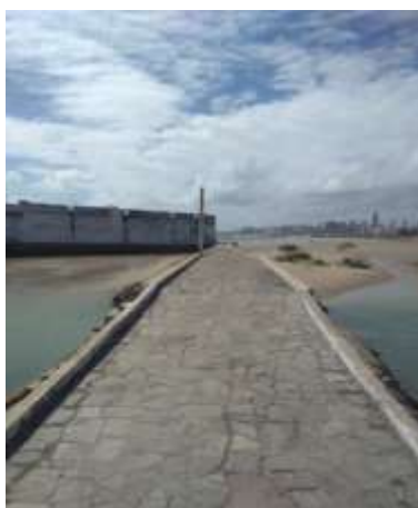
Figura 3 – Passarela de acesso. Fonte: Dados da pesquisa, 2018.
