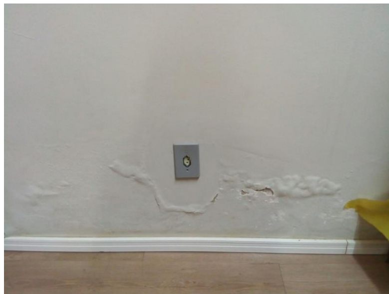
Figura 5 - Infiltrações
