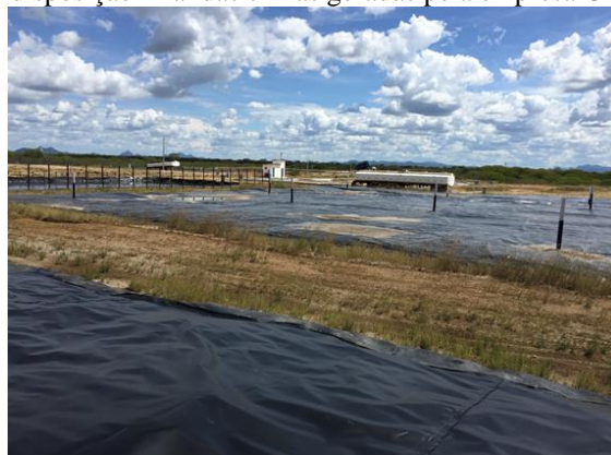
Figura 2.2 - Diques do aterro industrial para disposição final das cinzas geradas pela empresa Cril.
