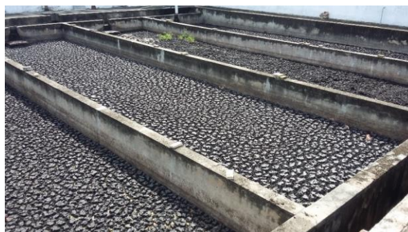
Figura 3 – Leitos de secagem do lodo da UFRN
