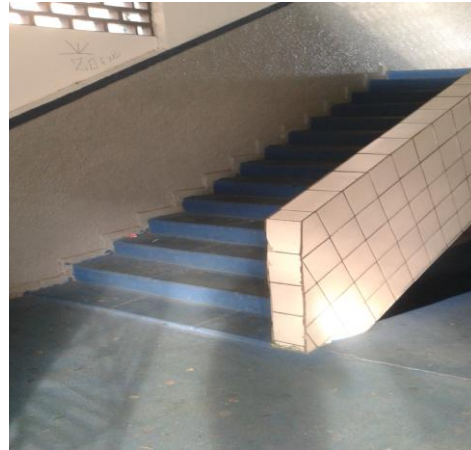
Figura 7: Acesso do piso térreo ao pavimento superior.
