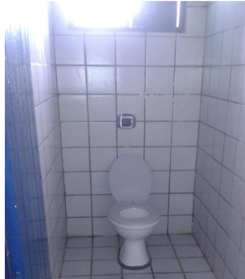
Figura 10: Instalações hidrossanitárias. Descrição: No centro da imagem um acento sanitário branco, piso e paredes de azulejo sem nenhum tipo de barra ou sinalização. Fonte: Arquivos da autora. Natal/jun./2016.
