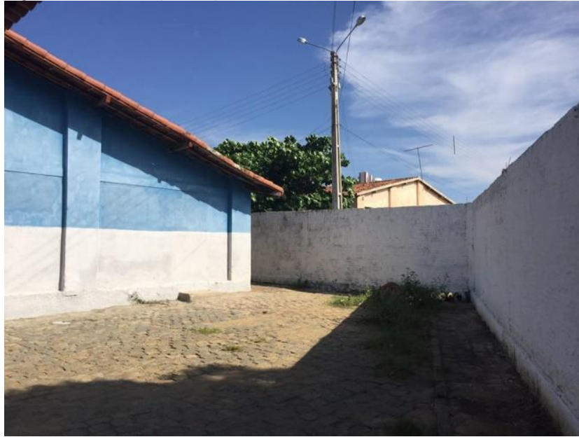
Figura 2 – Muro que separa as Aldeias SOS da escola
