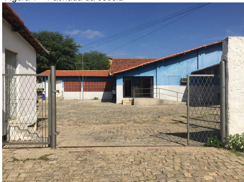
Figura 1 – Fachada da escola
