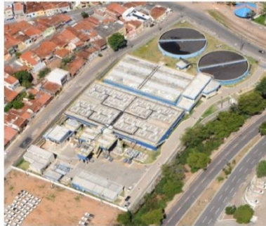
Figura 2 - Vista aérea da ETE
